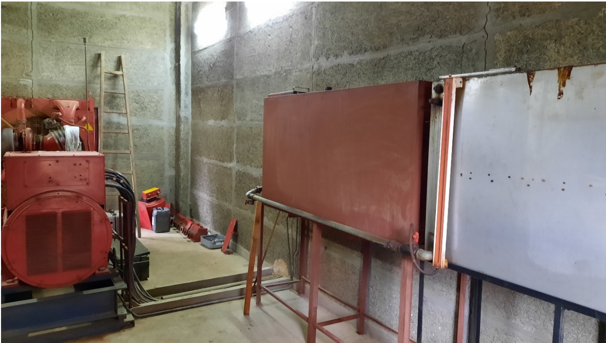
Εικόνα 4: Δεξαμενή πετρελαίου που αποξηλώνεται.
