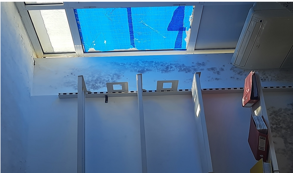
Εικόνα 3. Υγρασία στο Δώμα του Αρχείου
