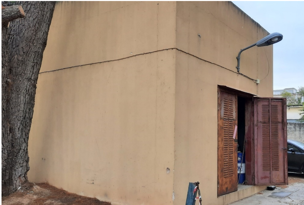
Εικόνα 6: Θύρα χώρου Η/Ζ 625KVA που αποξηλώνεται
