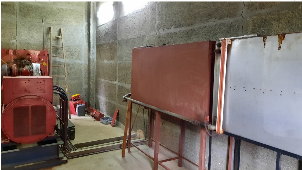
Εικόνα 4: Δεξαμενή πετρελαίου που αποξηλώνεται.
