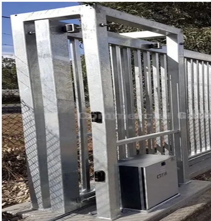
Εικόνα 7. Διπλό μεταλλικό πλαίσιο στήριξης (ενδεικτική φωτογραφία)
