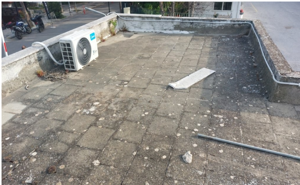
Εικόνα 5 . Δώμα του Φυλακίου
